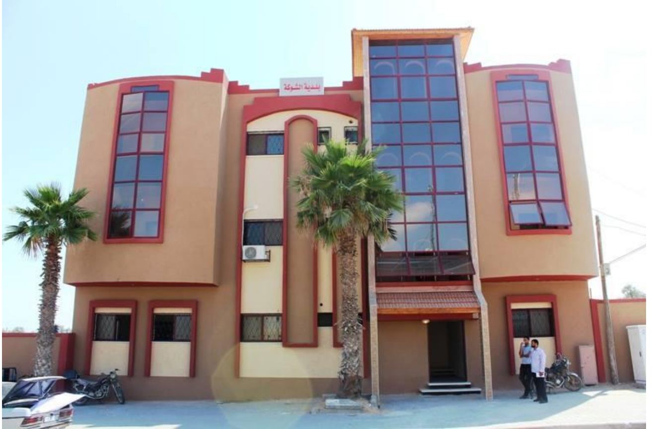
شكل (1) : مبنى بلدية الشوكة
