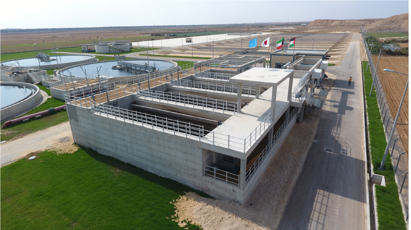
صورة توضح محطة معالجة مياه الصرف الصحي -الفخاري
